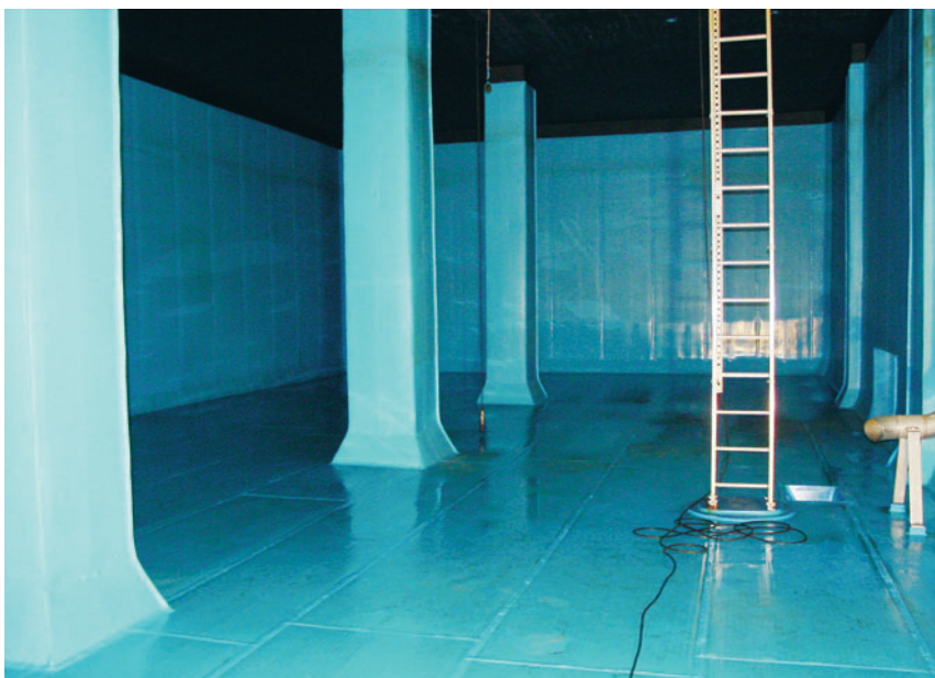
Abb. 8 Der Reinwasserbehälter nach seiner Sanierung
