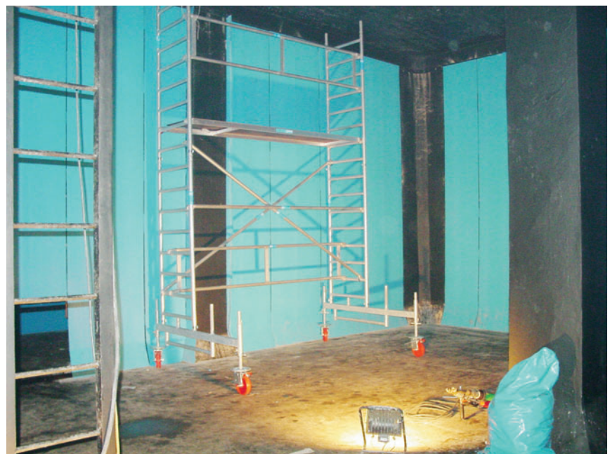
Abb. 6 Auskleidung der Behälterwand mit PE-HD-Platten
