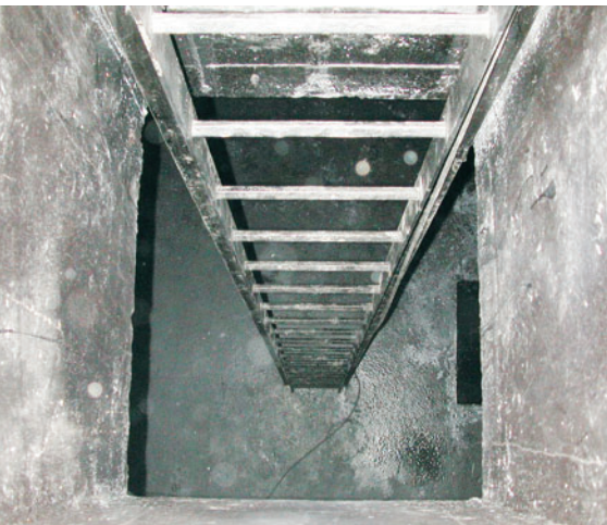
Abb. 2 Reinwasserbehälter vor der Sanierung
