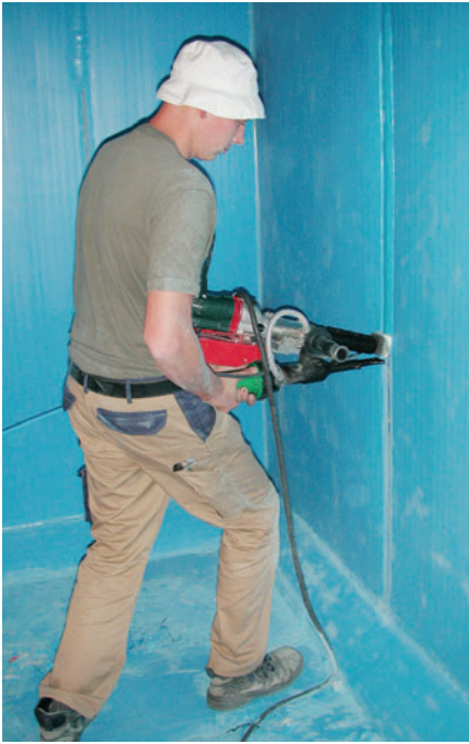
Abb. 5 Schweißvorgang und Verbindung der PE-HD-Platten
