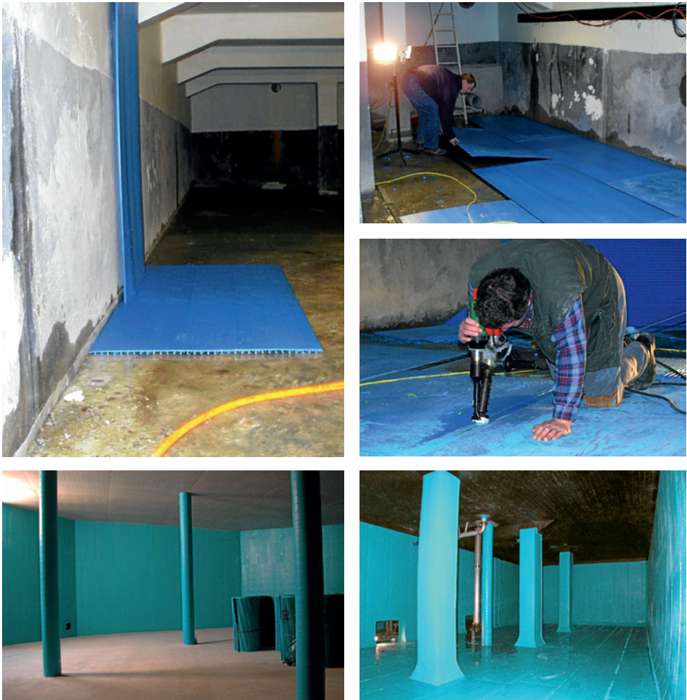
Bild 6.6.6.1.02a-e: Wasserkammerauskleidung mit BKU-aqua®-PE-HD-Stegplatten (BKU II)
